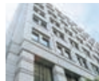
笹塚センタービル
