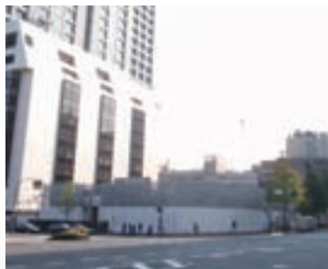
建設工事現場の状況(本年10月現在)
